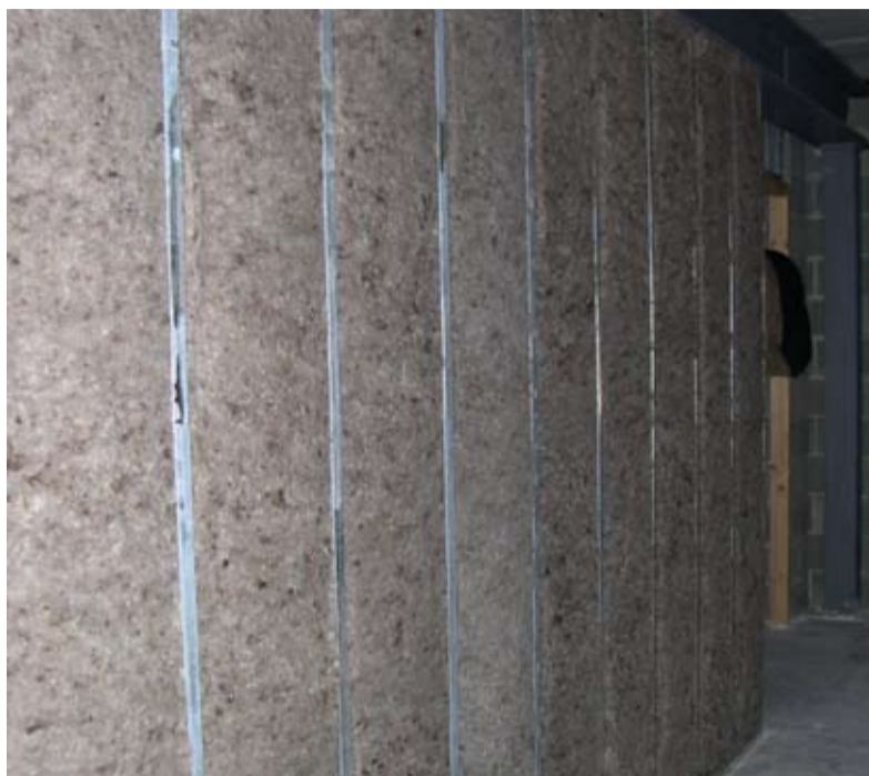
TERMOFITEX LAN 40: EL MATERIAL COL·LOCAT EN OBRA
